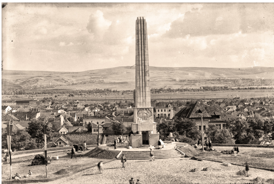
3. Șantierului Obeliscului „Horea Cloșca și Crișan”.
